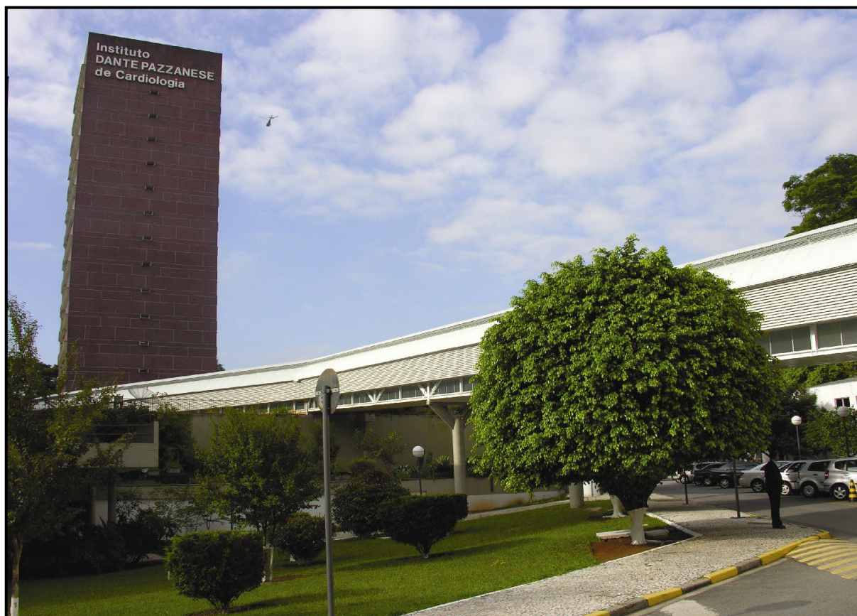
Torre que abriga a FAJ – Fundação Adib Jatene e a passarela de ligação entre Edifício Adib D. Jatene e Edifício J. Eduardo M.R. Sousa
